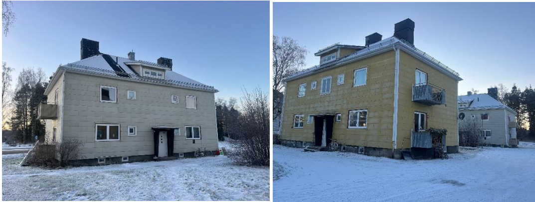
Fönster bytta och eternitplattor skadade på två av byggnaderna. Foto 2024-12-03
